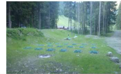
Filière à base de média coco 180 EH (2 FTES 45+35m3 - 6 x 30eh) – Auberge Nordique_Station Ski de Fond_Le Grand Bornand
