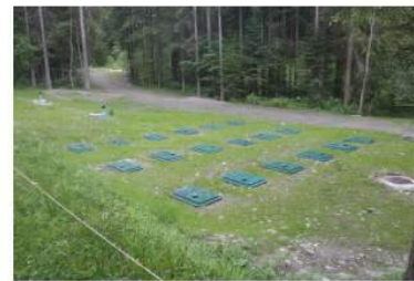
Filière à base de média coco 180 EH (2 FTES 45+35m3 - 6 x 30eh) – Auberge Nordique_Station Ski de Fond_Le Grand Bornand
